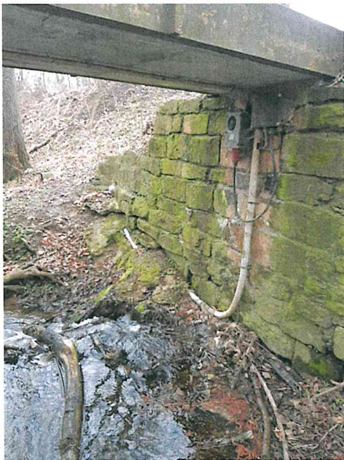
Abbildung 12: Stromanschluss
