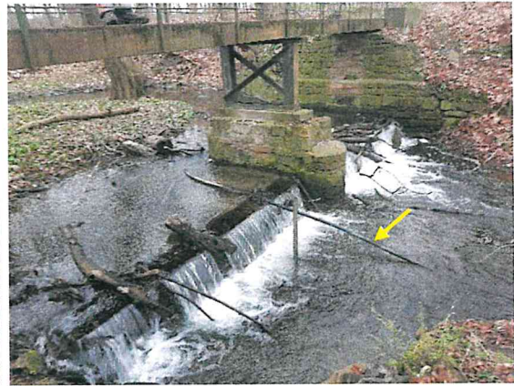
Abbildung 11: Staustufe mit Leitung
