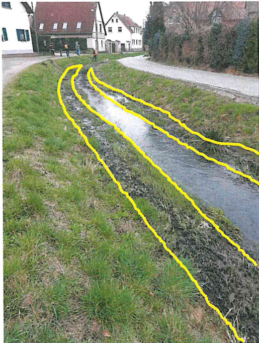
Abbildung 27: Grundräumung Schlammablagerungen
