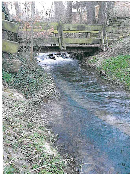
Abbildung 18: Private Überfahrt mit Steindamm im Oberlauf
