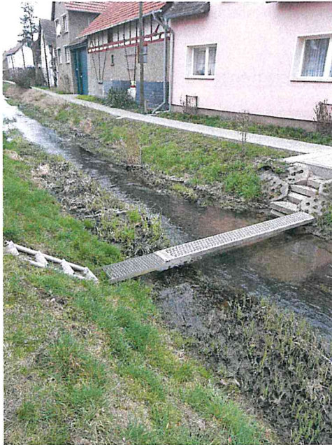
Abbildung 28: abflussbehindernder Steg
